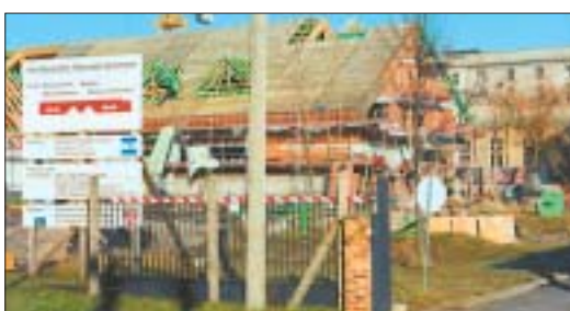
1994: Neubau des Maschinenhauses im Wasserwerk Tettau.
