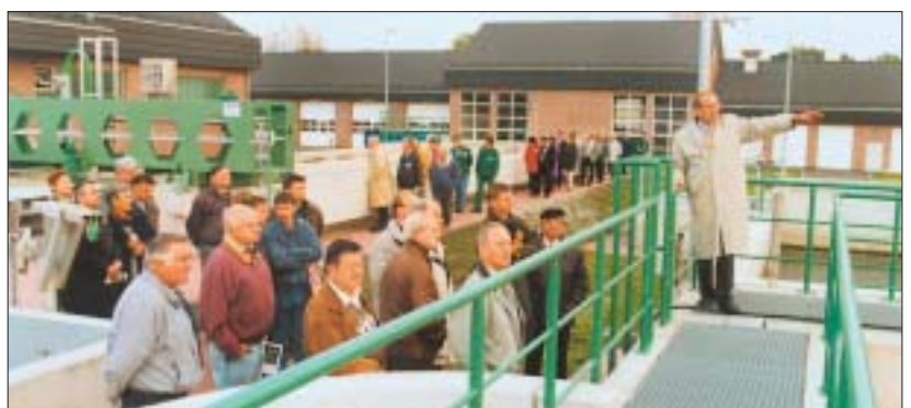
Ein Meilenstein auch für viele interessierte Kunden – die Inbetriebnahme der Kläranlage Brieske am 22. 10. 1997.
