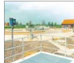
Die Kläranlage Großthiemig reinigt Abwasser für 5.000 Einwohnerwerte.
