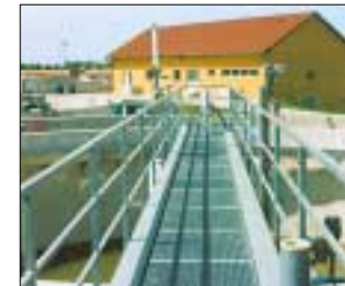
Hier wird seit 1995 das Abwasser von Großbräschen gereinigt (Kapazität: 25.000 EW).
