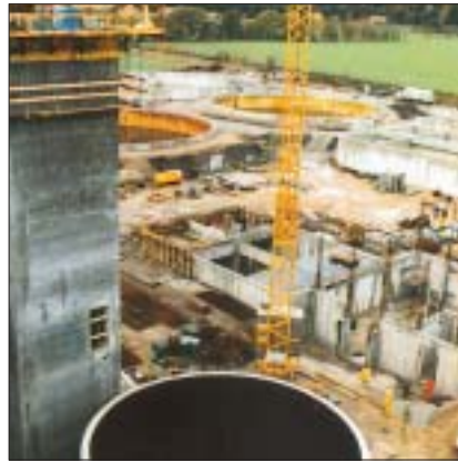
1995 – der Bau der neuen Kläranlage in Brieske macht sichtbare Fortschritte.
