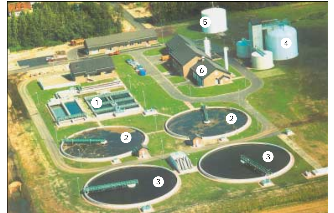
Die Anlage in Brieske ist mit einer Auslegung für 60.000 Einwohnerwerte die größte der insgesamt sieben Kläranlagen des Wasserverbandes Lausitz. Aus der Luft gut zu erkennen sind die Vorklärbecken (1), die biologischen Belebungsbecken (2) und die Nachklärbecken (3). Rechts oben befindet sich der Faultrum (4). Vom Gasspeicher (5) wird dieser Energieträger zum Blockheizkraftwerk (6) geleitet.
